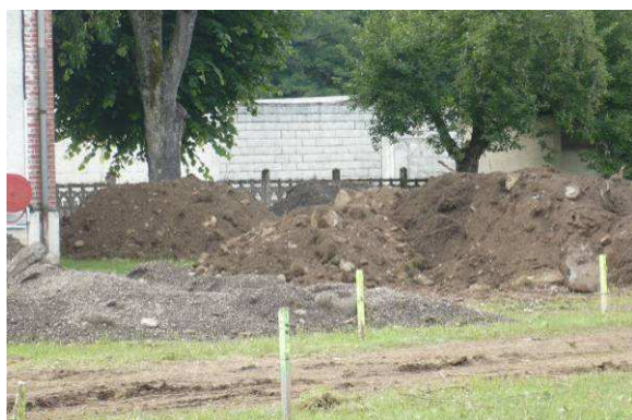
Stockage des terres régalées
