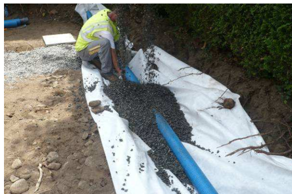
Mise en place du géotextile et du réseau de drainage
