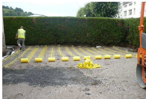
Mise en place du grillage avertisseur
