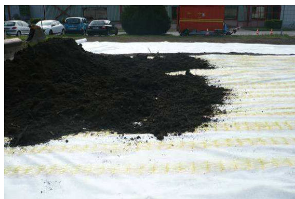
Mise en place de la terre végétale
