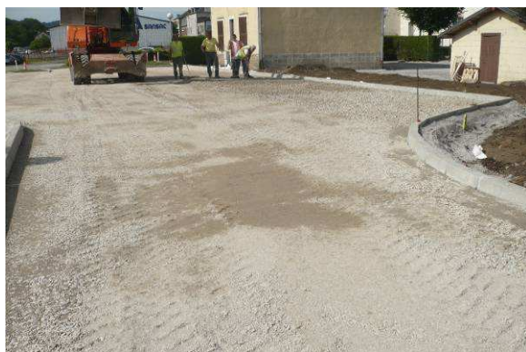
Aménagement de la zone parking
