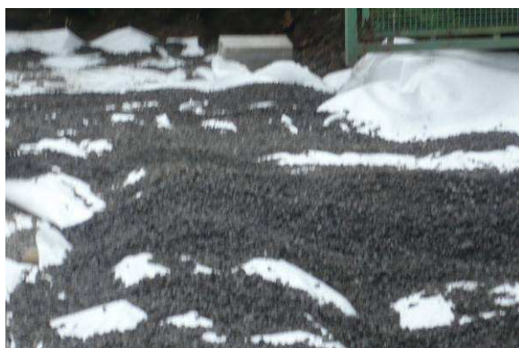
Mise en place de la couche de forme
